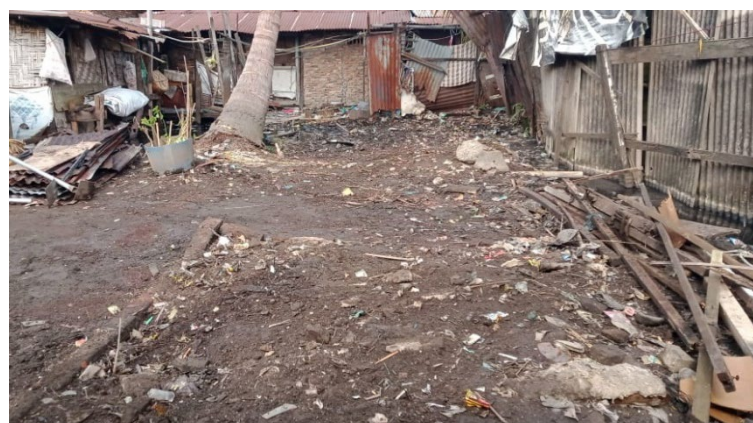
Gambar 16. Land Clearing Lokasi Pembangunan Model Jamban Sehat
