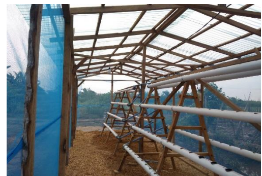
Gambar 1. Gambar bangunan dan Alat Hydronik
