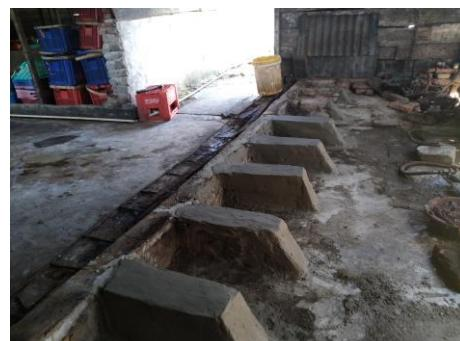
Gambar 3.3. Pembetonan bagian dudukan alat kukus
