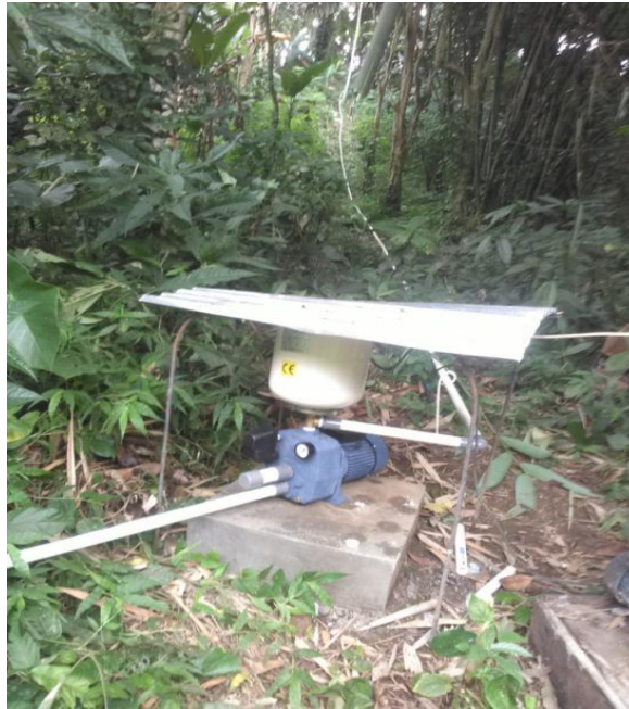
Gambar 3.5. Pembuatan pondasi pompa dan pompa jet pump baru beserta jalur pemipaan
