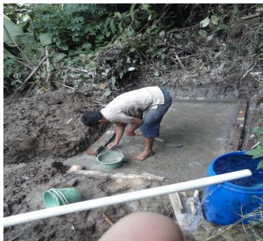
Gambar 3.3. Pembuatan pondasi dan pemasangan tangki penampungan
