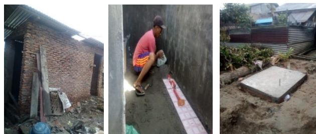
Gambar 5.2 (a) Pemasangan Batu pada Dinding Kamar Mandi, (b) Plaster Dinding dan Lantai Kamar Mandi, (c) Unit Septic Tank
