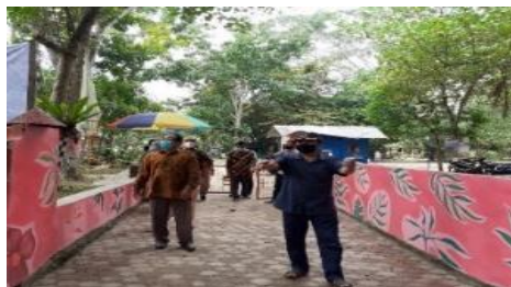
Gambar 3.5 Perbaikan Tembok di Pintu Masuk
