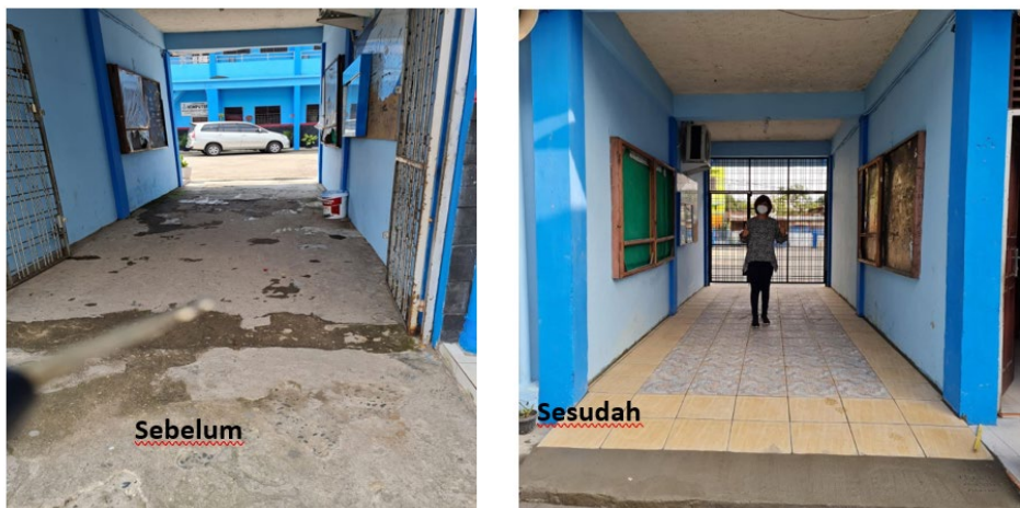
Gambar 8. Renovasi lantai, pengecoran dan pemasangan keramik
