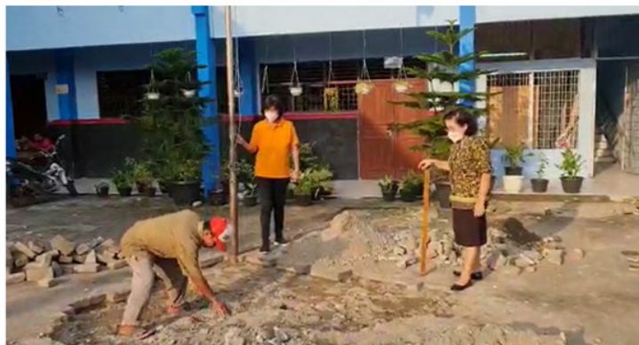
Gambar 6. Pembongkaran paving blok
