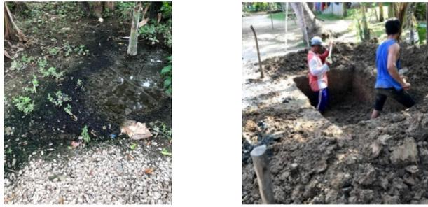
**Gambar 1** (a) Penentuan Lahan untuk Septic Tank, (b) Penggalian *Septic tank*
