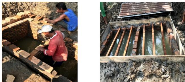
**Gambar 3.** (a) Pembangunan Dinding Septic Tank, (b) Pemasangan Tiang Penutup Septic Tank
