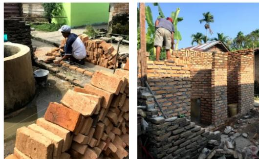
**Gambar 2** (a) Pemasangan Batu untuk Pembuatan Dinding, (b) Proses Pembangunan Dinding Kamar Mandi
