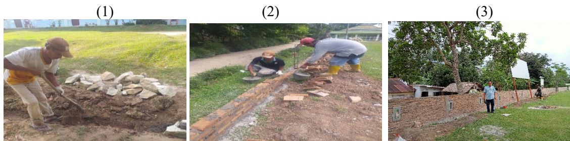
Gambar 5. Proses Pembangunan Pagar
