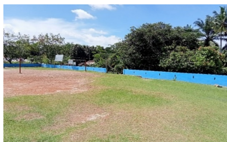
Gambar 6. Pembangunan Pagar Telah Selesai
