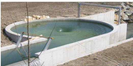
Gambar 2.5 Turbin vortex Zotlöterer
