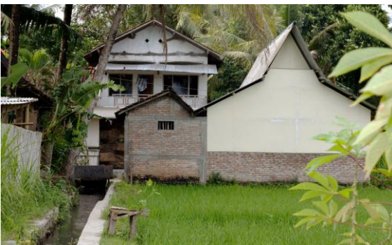
Gambar 12. Dinding bata yang dikombinasikan dengan panel dinding fibercement Sumber: Shim, Brigitte., 2010
