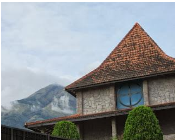
Gambar 3. Sudut atap dengan kemiringan yang curam sebagai ciri khas bangunan daerah tropis Sumber: Kisah Ziarah, 2013
