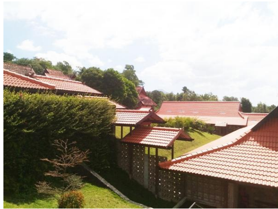
Gambar 4. Bentuk atap kmapung jompongan, perpaduan atap limasan dan atap pelana Sumber: Begini Heningnya, 2016
