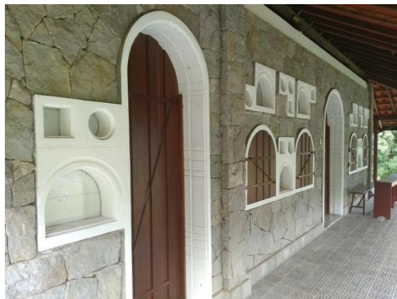
Gambar 5. Dinding menggunakan batu alam, dengan jendela dan ventilasi untuk pencahayaan dan penghawaan alami Sumber: Begini Heningnya, 2016
