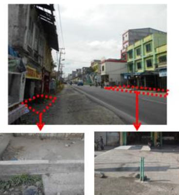
Gambar 18. Kondisi Eksisting Jalur Pejalan Kaki pada Segmen III Koridor Sei Rampah
