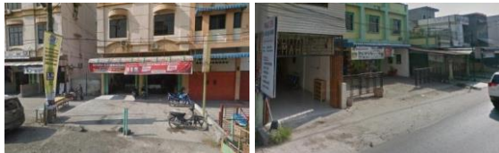
Gambar 15. Kondisi Eksisting Jalur Pejalan Kaki pada Segmen II Koridor Sei Rampah
