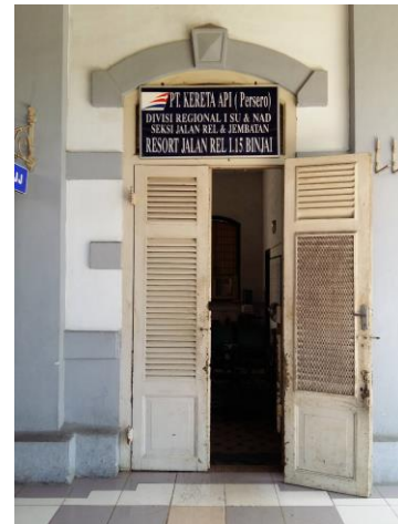
Gambar 8. Pintu Double Swing pada Stasiun Kereta Api Binjai
