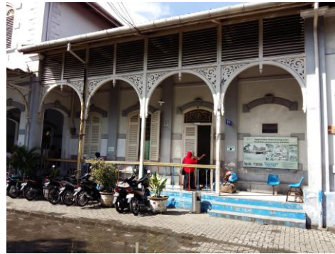
Gambar 22. Ornamen Melayu pada Bagian Selasar Depan Stasiun Kereta Api Binjai
