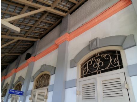
Gambar 10. Bovenlicht pada Pintu dan Jendela Stasiun Kereta Api Binjai
