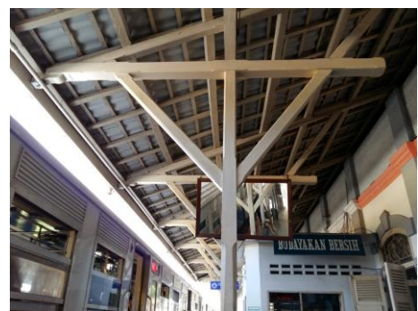
Gambar 19. Sambungan Kayu pada Tiang Peron Stasiun Kereta Api Binjai
