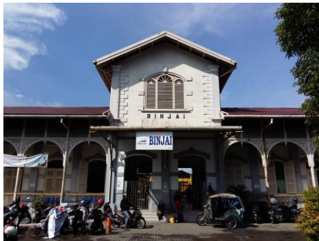
Gambar 5. Gable dan Tower pada Bagian Pintu Masuk Stasiun Kereta Api Binjai
