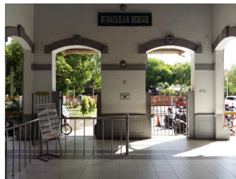
Gambar 13. Dado pada Dinding Stasiun Kereta Api Binjai
