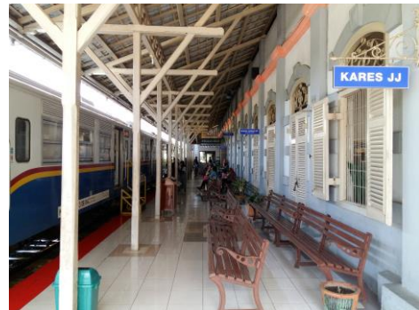
Gambar 18. Deretan Tiang pada Peron Stasiun Kereta Api Binjai
