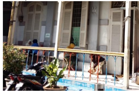
Gambar 7. Balustrade di Selasar Depan Stasiun Kereta Api Binjai
