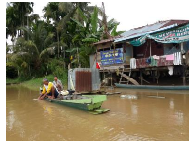
Gambar 4. Kondisi Sarana dan Prasarana
