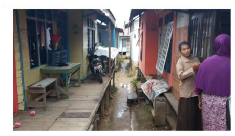
Gambar 6. Kondisi Bangunan pada Kawasan
