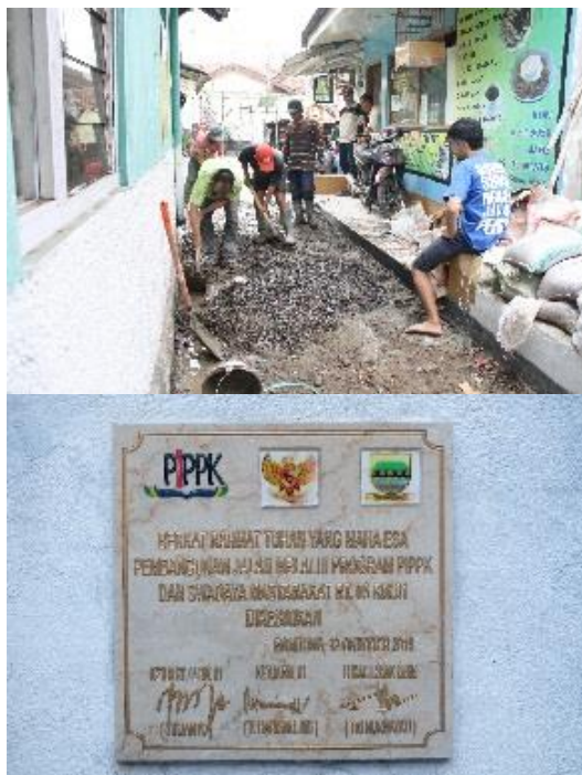
Gambar 1. Kegiatan Perbaikan Jalan (Kiri) dan Prasasti Peresmian Jalan (Kanan)
