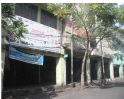
Gambar 12. Trotoar di Kampung Kung Fu
