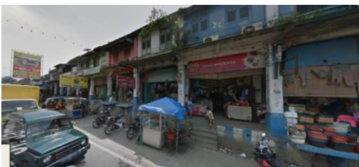
Gambar 14. Kondisi Bangunan Ruko Cina Melayu yang Ditutupi oleh Sistem Tata Informasi di Pancur Batu
