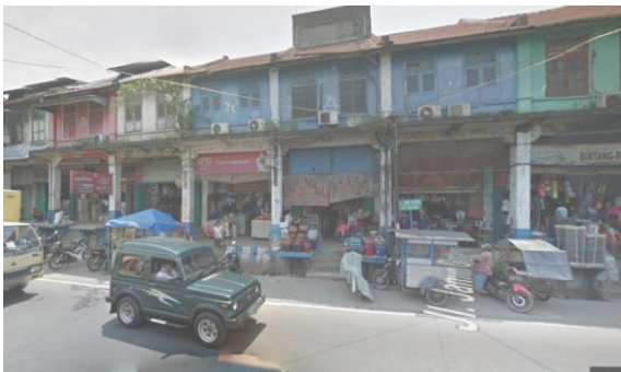
Gambar 2. Kondisi Fisik Fasad Bangunan Ruko Cina Melayu di Pancur Batu
