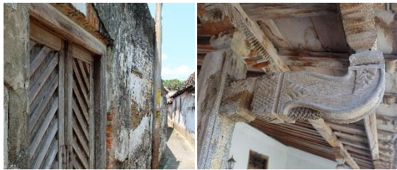
Gambar 12. Kondisi Material Bangunan Salah Satu Rumah Tradisional
