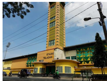
Gambar 5. Kondisi Stadion Teladan Medan pada 2017
