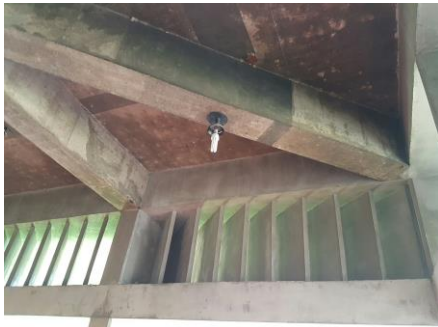
Gambar 11. Ekspresi Arsitektur yang Jujur dengan Menggabungkan Kisi-kisi Menjadi Bagian dari Konstruksi Bangunan
