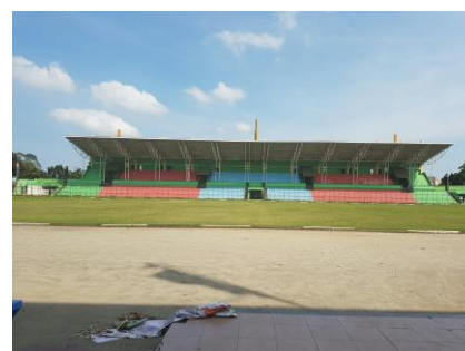
Gambar 6. Kondisi Tribun Stadion Teladan Medan yang Direnovasi dengan Menambahkan Atap
