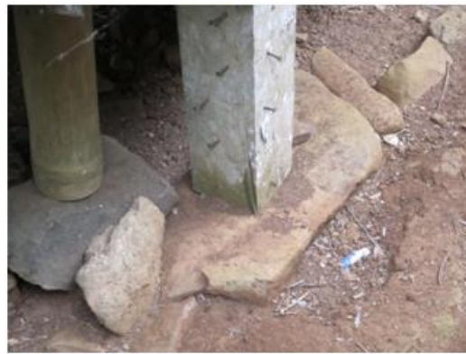
Gambar 29. Pondasi batu kali yang menapak pada tanah keras
