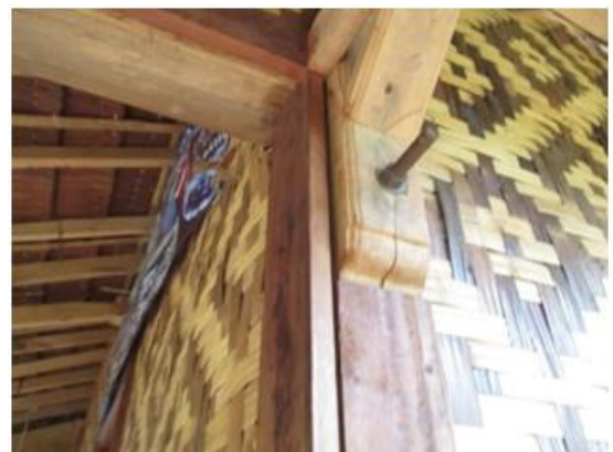
Gambar 34. Detail kolom yang menggunakan besi anker sebagai penguat bangunan
