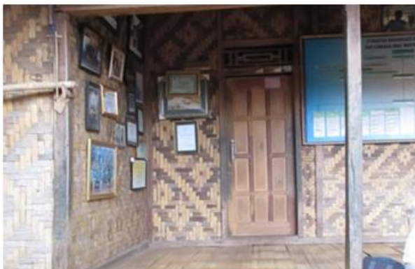
Gambar 23. Kolom kayu menghubungkan antara balok lantai dengan balok atap, paku sebagai media penguat pada rumah ketua adat
