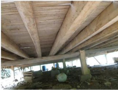
Gambar 30. Balok-balok kayu penahan beban tekan dari lantai yang kemudian disalurkan ke pondasi batu kali yang menapak pada tanah keras
