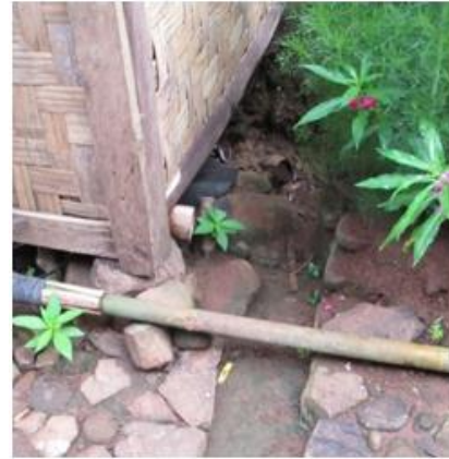
Gambar 44. Pondasi jamban Baduy Luar 1
