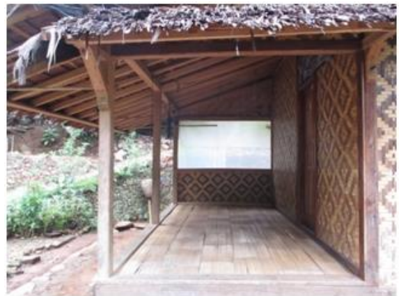
Gambar 33. Kolom pada rumah Baduy Luar 1
