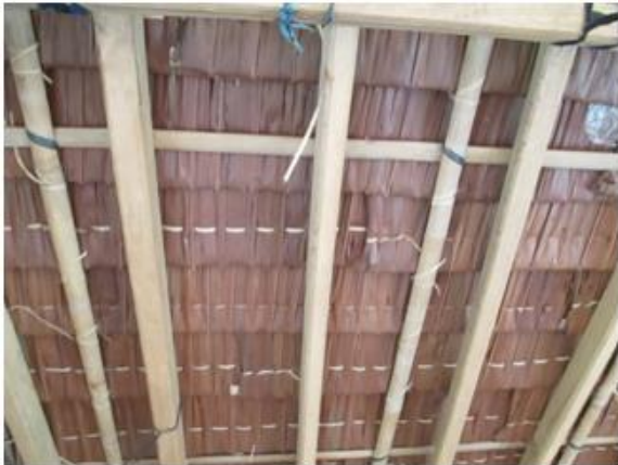
Gambar 36. Penggunaan atap daun kelapa kering sebagai penutup atap sekaligus sebagai langit-langit bangunan pada rumah Baduy Luar 1
