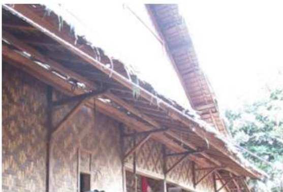
Gambar 27. Rangka kanopi atap menggunakan bambu utuh berdiameter 4 cm
