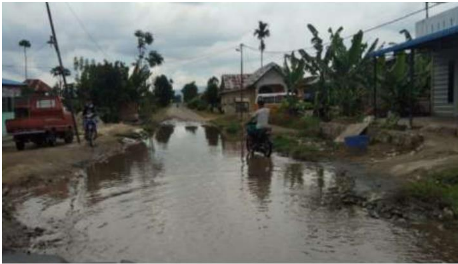
Gambar 1.1 Kondisi Jalan Menuju Desa Salit
